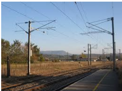
Figure 2.3 Poteaux pour lignes caténaires
