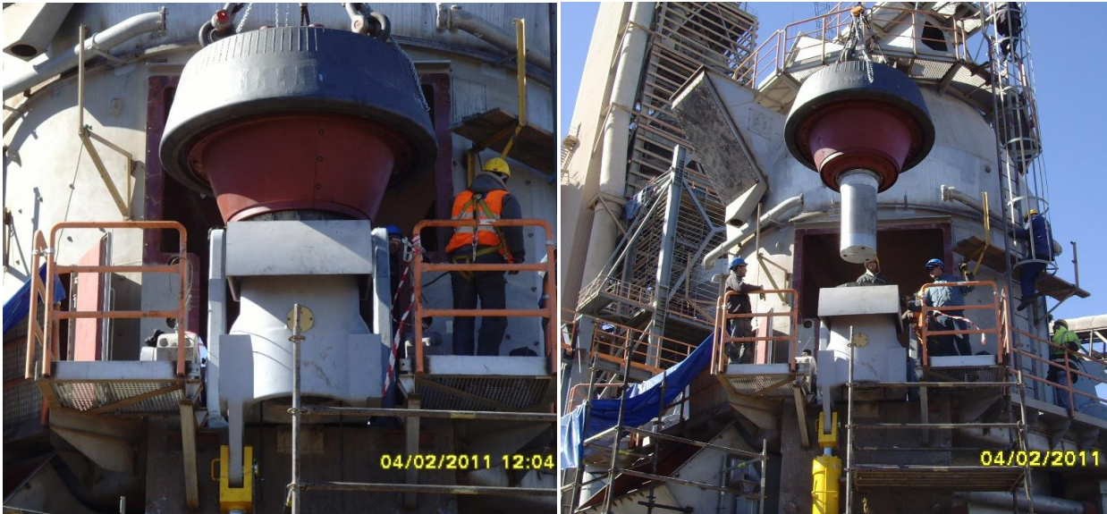
Figure 2-7 : Exemple de démontage du galet N°1 à l'aide d'une grue
