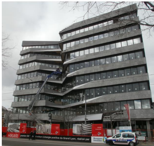
Figure 6.5 : La façade est de l'îlot Hikari en avril 2015 – Photo prise par l'auteur - Avril 2015
