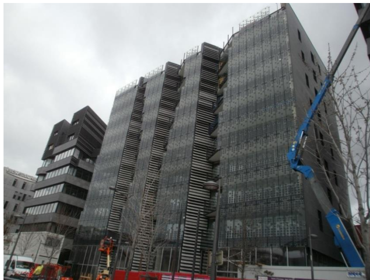
Figure 6.7 : La "centrale solaire" en façade de l'îlot Hikari – Photo prise par l'auteur - Mai 2015
