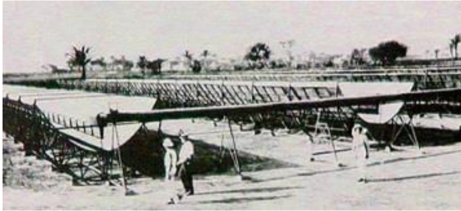
Figure 1-1: Vue des récepteurs solaires de Shuman
