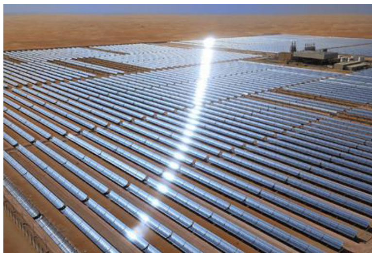
Figure 1-4 : Vue aérienne des capteurs solaires de la centrale cylindro-parabolique de Shams, à Abu Dhabi. (Source : Shams Power group)
