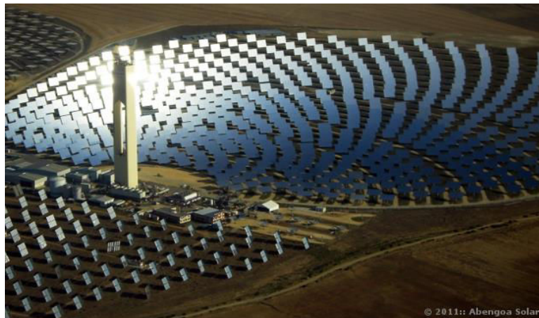
Figure 1-14 : Vue de la centrale PS20 (source : Abengoa Solar)
