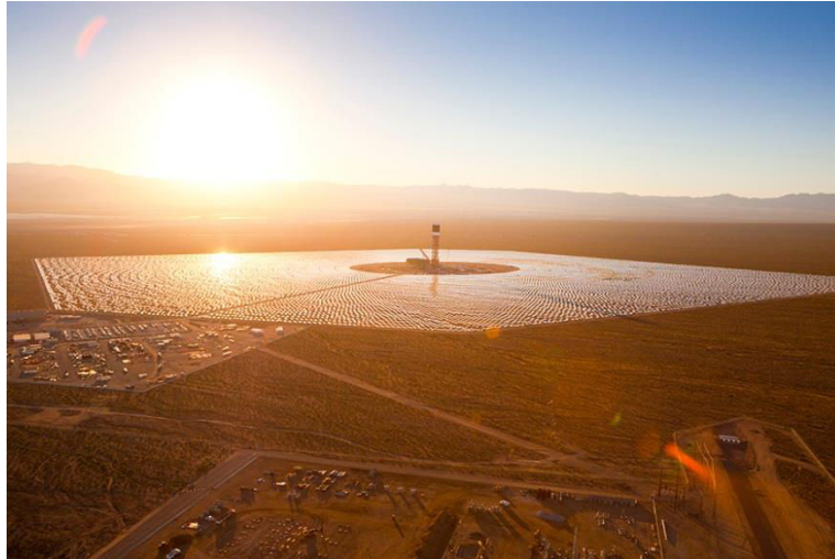
Figure 1-15 : Vue d'une unité de la centrale Ivanpah (source : Ivanpah Solar)
