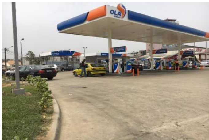
Figure V-15 Enseigne station d'essence OLA
