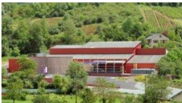
Figure 22 : Extérieur de la cave coopérative de Valady 1
