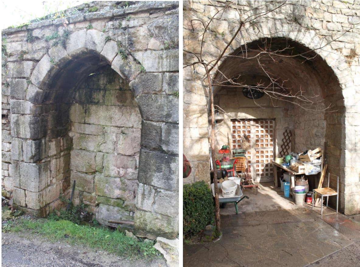
Figure 63 : Fontaine de la grange de Bougaunes 1 entrée de la cave de Bougaunes 2
