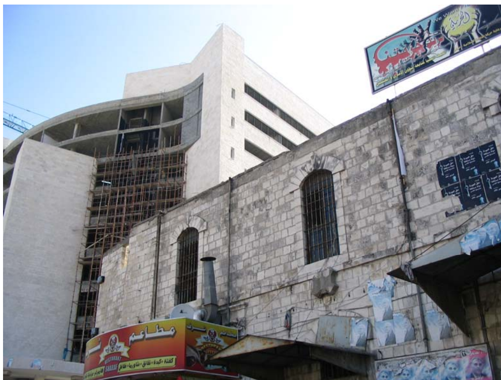
Photo 7. La savonnerie Tûqân dominée par le Mall en construction. En bas à gauche, l'enseigne des falâfel-s Sharaf .
