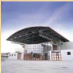
■ Gestion technique des bâtiments
