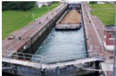
■ Gestion d'automatismes d'une écluse
