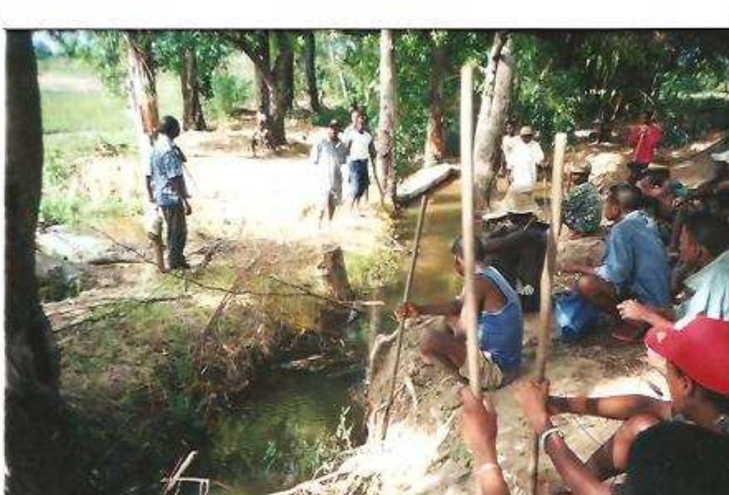
Figure 11 : Déserbage des canaux
