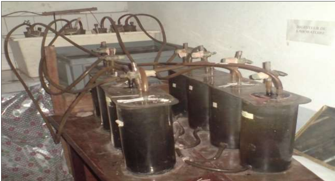
Figure 17: vue générale de l'installation
