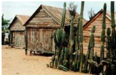
Figure 46 : Maison sur Pilotis.
