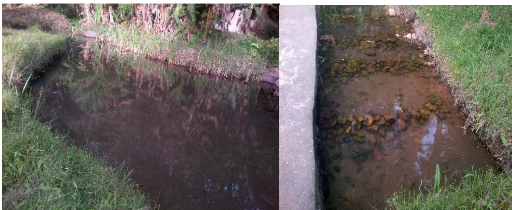
Figure 9 : Bassin de sédimentation
