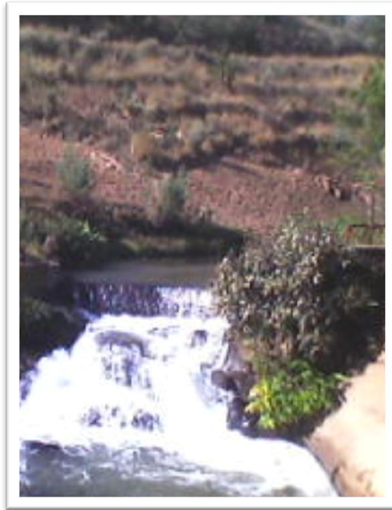
Photo 9 : Rochers constituant l'aval immédiat du barrage
