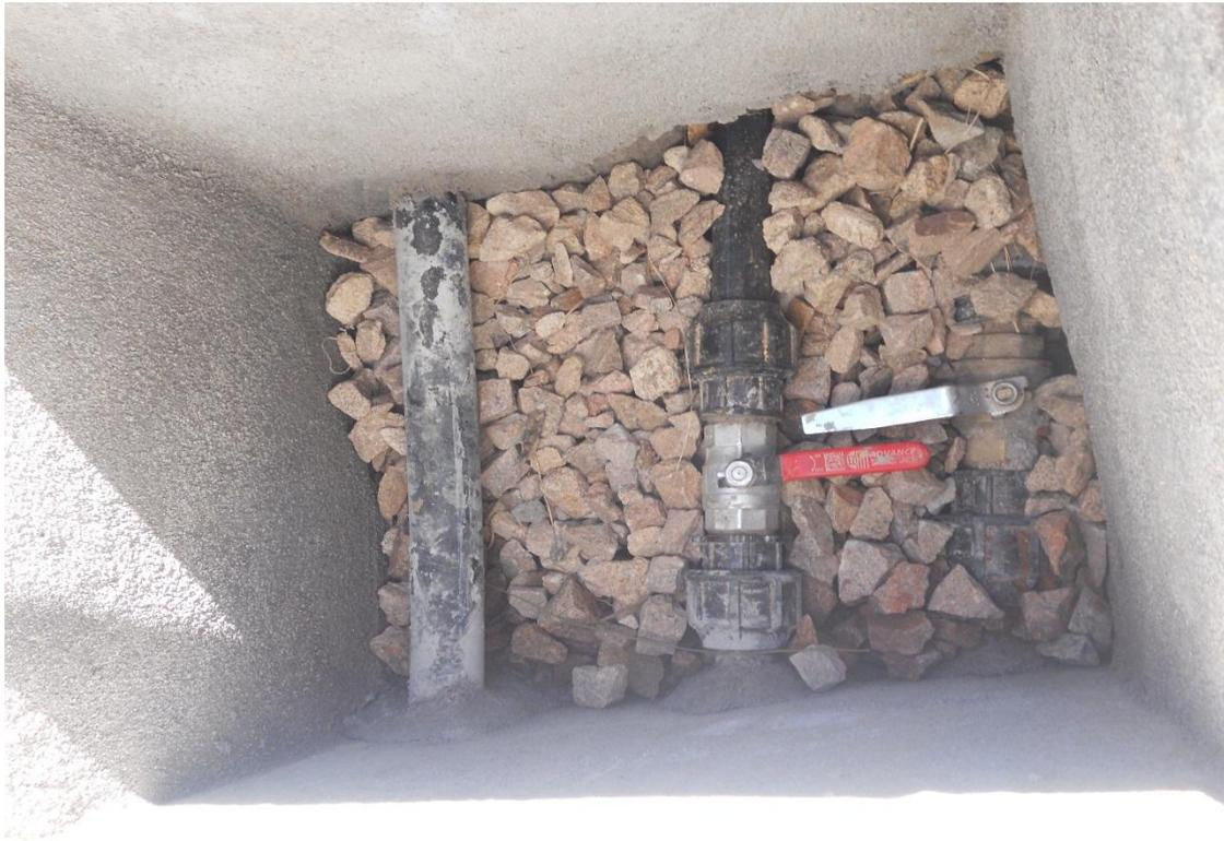
Figure n°10 : La chambre des vannes
