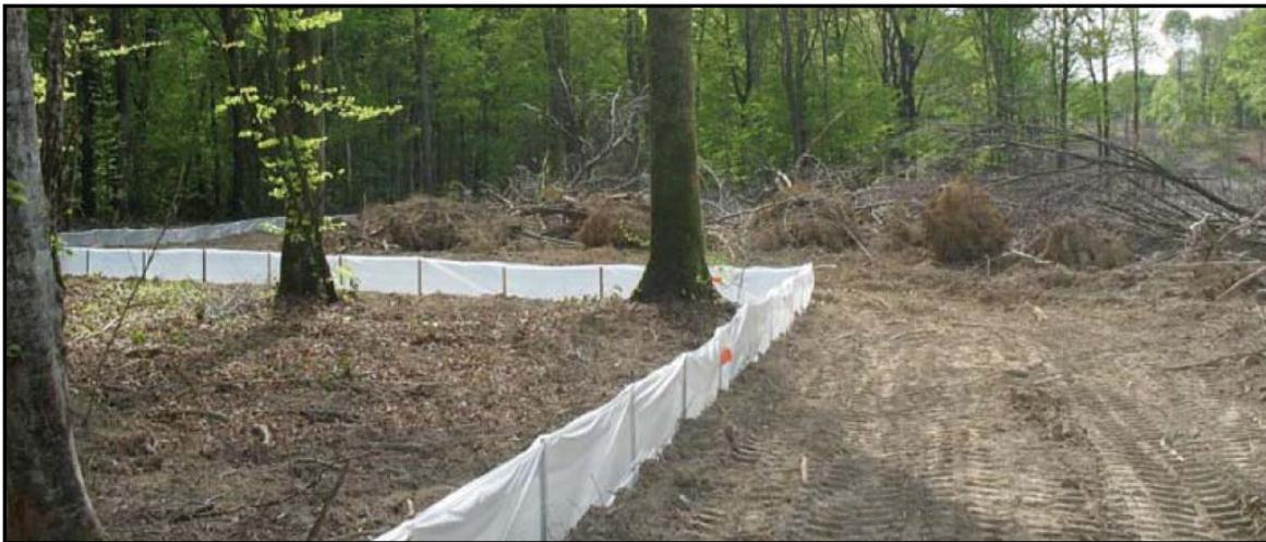
**Figure 21 : Les mesures prises en phase travaux : clôtures pour les amphibiens**
