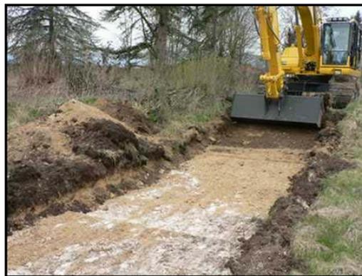
Figure 2 : Zoom sur une tranchée de sondage
