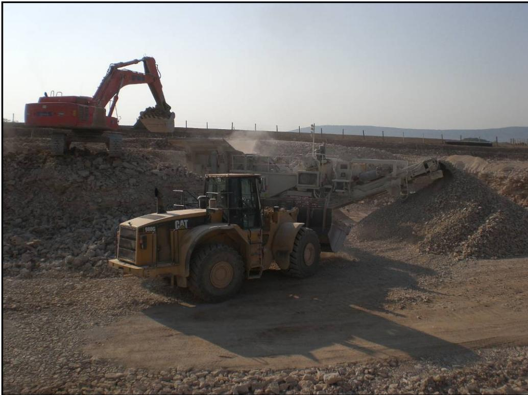
Figure 40 : Atelier de concassage dans l'emprunt de Neuville
