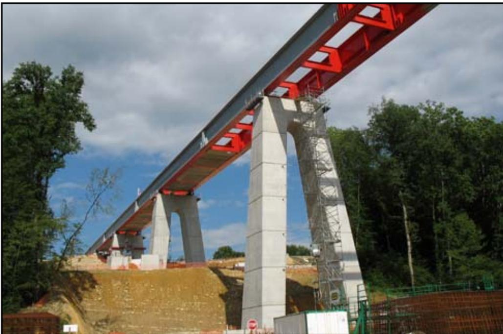
Figure 1 : Pose du *tablier\** du viaduc de la Linotte - Ormenans
