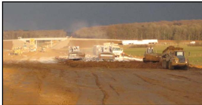
Figure 18 : Mise en œuvre du corps de remblai + traitement aux liants hydrauliques\*
