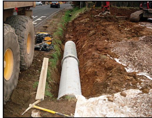
Figure 36 : Pose de buses béton
