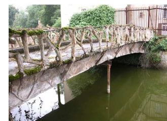
Pont bi-poutre de Chazelet, 1875, Joseph Monier
