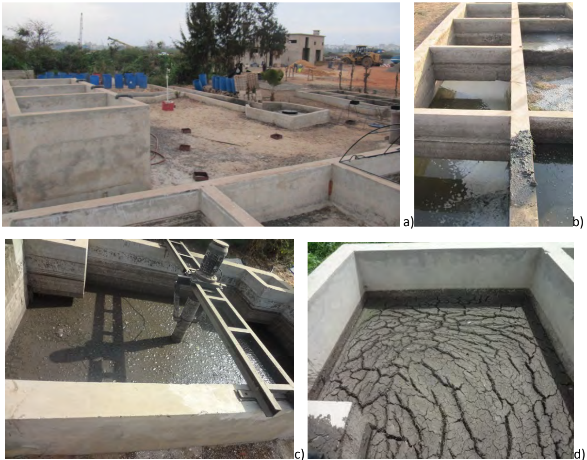
Figure 4.4: Station expérimentale (a) avec bassin de décantation-épaissement (b), bassin de mixage (c) et lits de séchage non plantés (d)
