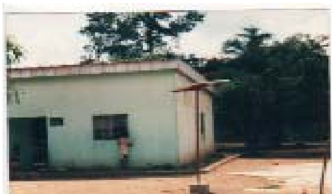
Un centre de santé équipé en panneaux photovoltaïques (Tangoumassou/Dimbokro)
