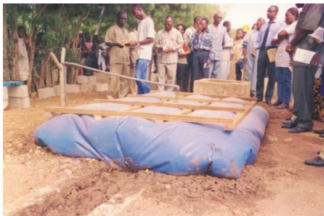
Unité de biogaz construite à Komborodougou pour une cantine scolaire (Nord de la Côte d'Ivoire)
