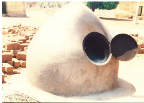
Four à pain modernisé de type ANKO*. On observe une importante surélévation par rapport au niveau du sol
