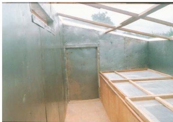
Intérieur d'un séchoir solaire à capteur intégré à l'enceinte chauffante (San- Pédro)
