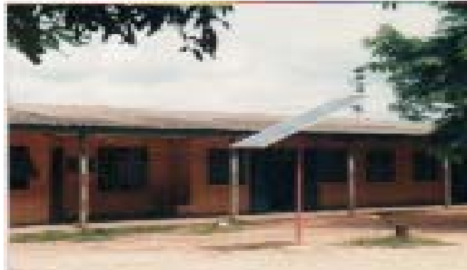
Une école primaire équipée en panneaux photovoltaïques (Kako/Grand-Béréby)
