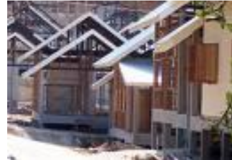
Maison construite au Sri Lanka, www.csld.edu/srilanka.htm
