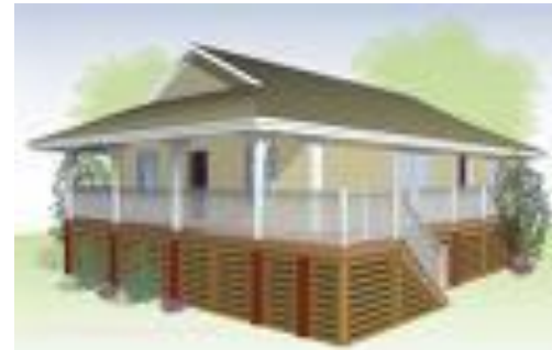
Maisons créoles ou tropicales avec toits clairs, avancées de toit, auvents, contre le rayonnement solaire direct.
