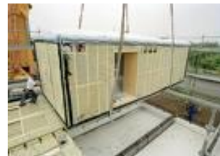
Système de construction par modules préfabriqués des maisons BOKLOK ↑
