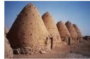
Architecture saharienne en terre (isolant).
