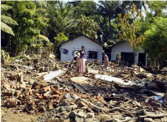
Destructions lors du Tsunami en Asie du Sud-est, en décembre 2004. (Ce Tsunami a provoqué 250.000 morts).
