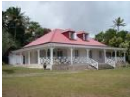
Maisons créoles ou tropicales avec toits clairs, avancées de toit, auvents, contre le rayonnement solaire direct.
