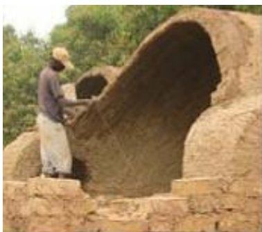
Figure 5 : construction d'une voûte avec inclinaison des rangs de briques [5]
