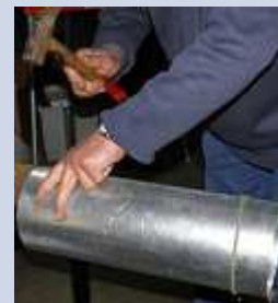
31. Fin du roulage du tuyau.
