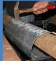
34. Martelage des points de soudure.
