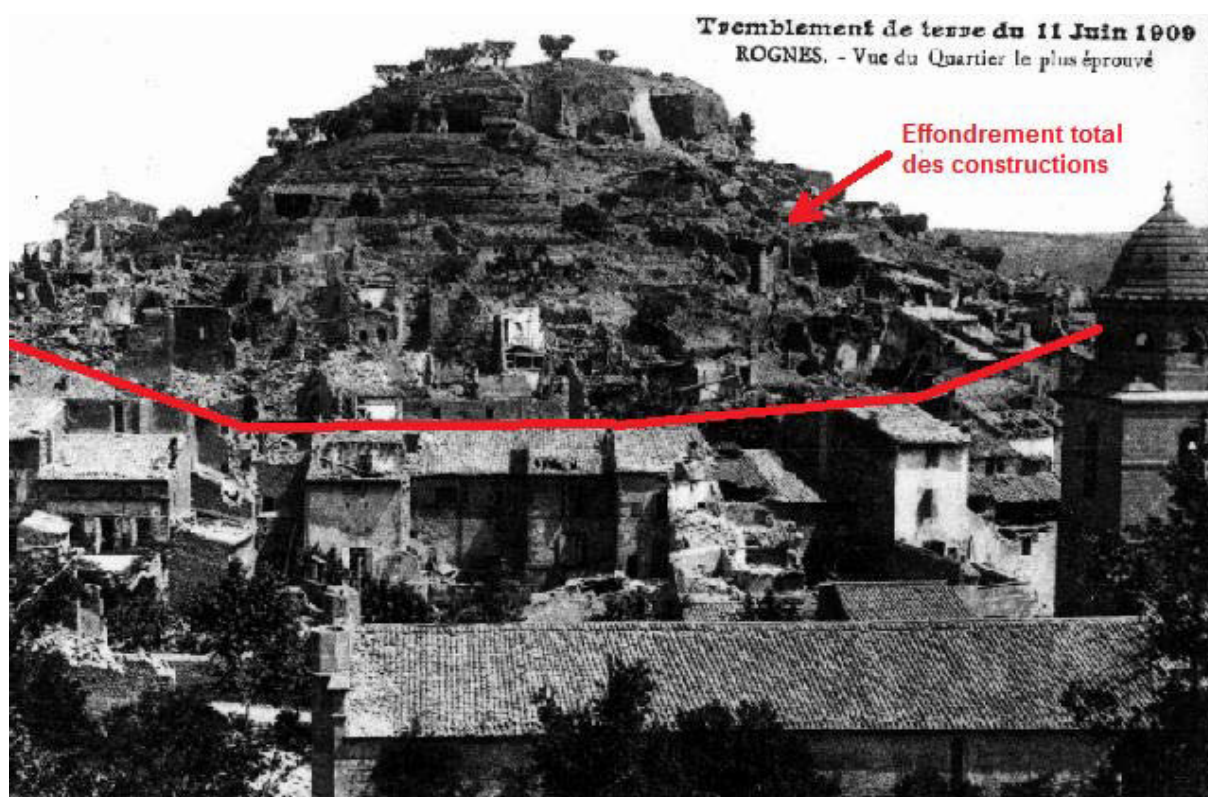
Figure 15. Variation spatiale des dégâts observée au village de Rognes (photo du site d'internet de l'association Les Amis du Vieux Rognes)
