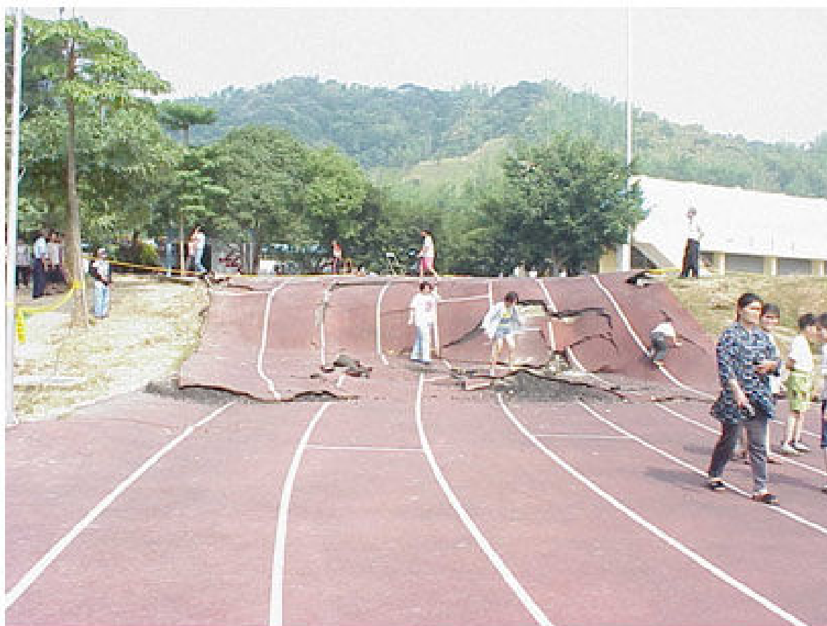
Figure 6. Déplacement vertical associé à l'émergence d'une faille lors du séisme de Chi-Chi à Taiwan, M_w=7.6 , en 1999 (photo de IRSN/AFPS)
