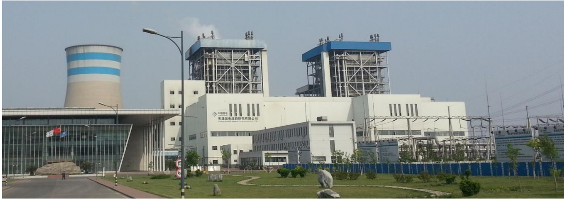
Figure 4 : Centrale thermique à charbon de Tianjin Guodian - Chine
