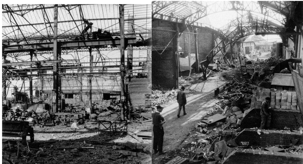
Figure 42- Intérieur de l'usine de Gennevilliers après les bombardements (grand hall de la Moto) de 1944 272
