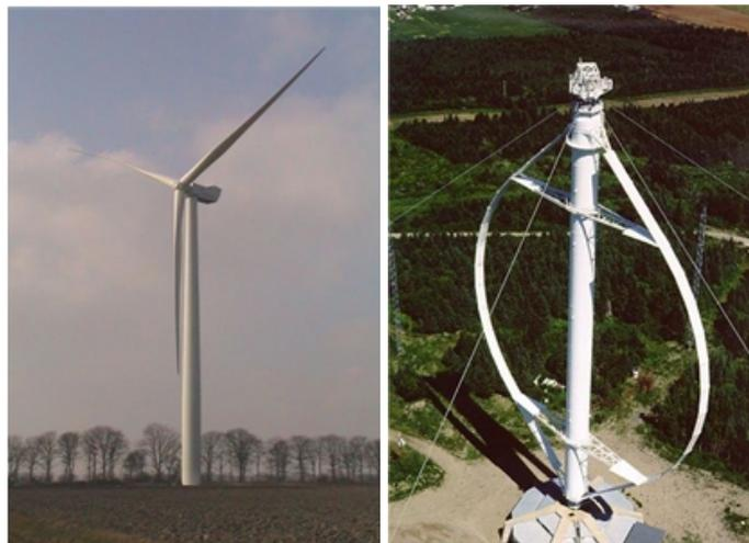
Figure 3 Éoliennes à axe horizontal et vertical utilisant la portance
