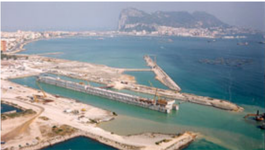
construction de la digue à Algésiras
