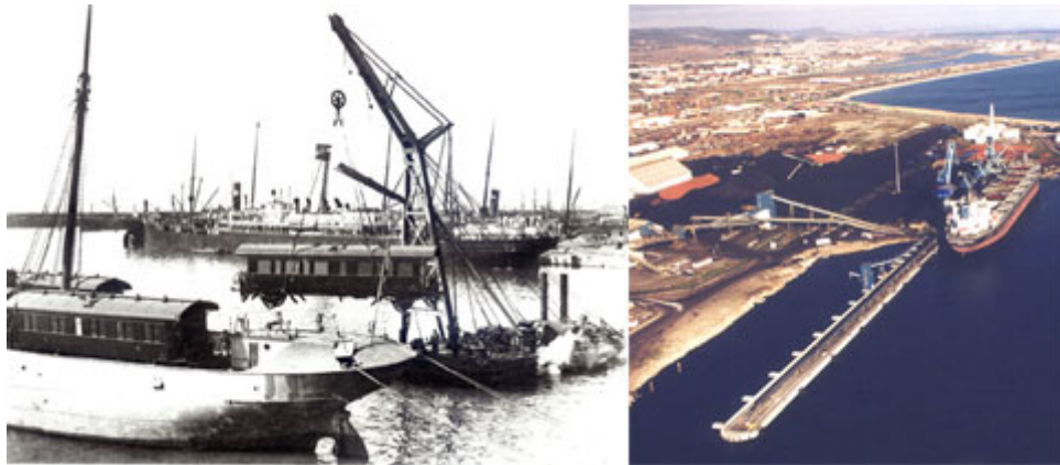
A gauche : Port de Marseille, déchargement d'un wagon au moyen d'une digue flottante.
