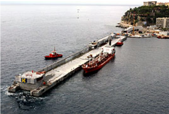
mise en place de la digue
