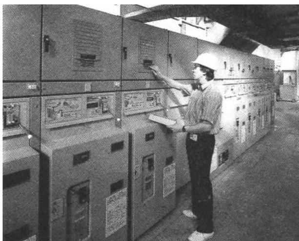
Figure 5 – Cellule disjoncteur MT *Fluair* débrochable à coupure et isolement dans le SF<sub>6</sub> (doc. Merlin Gerin)
