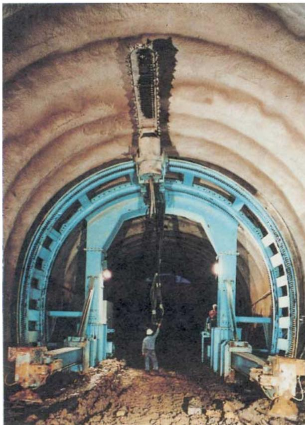
Figure 4 – Machine de prédécoupage pleine section. Méthode Perforex
