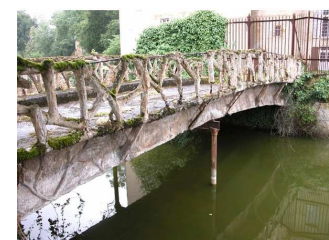
Pont bi-poutre de Chazelet, 1875, Joseph Monier
