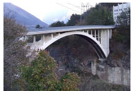
Pont du Sautet (Sud de Grenoble). Albert Caquot, 1928
