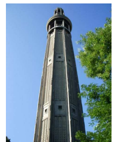
La Tour Perret
