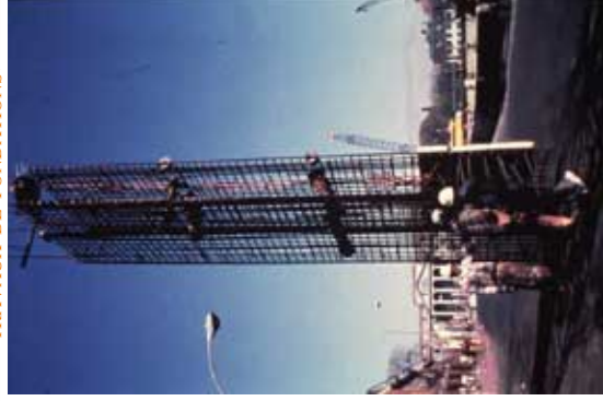
Illustration de l'exécution de la paroi moulée par panneaux alternés (primaires - secondaires)
