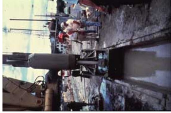
Illustration de l'exécution de la paroi moulée par panneaux alternés (primaires - secondaires)
