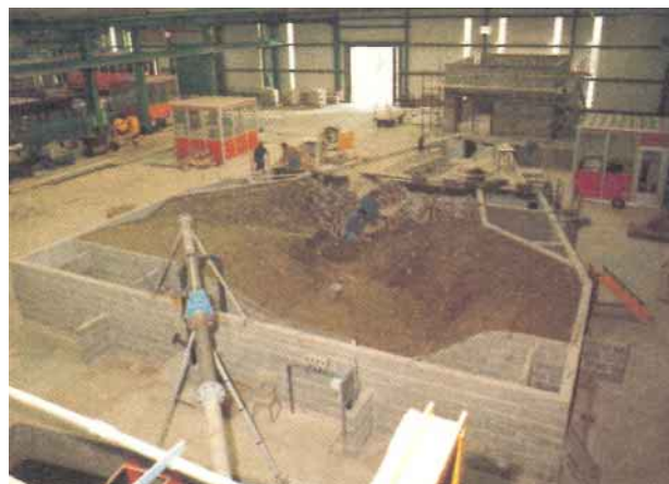
Figure 2 – Construction d'un modèle à fonds fixes : retenue de Serre-de-la-Fare.
