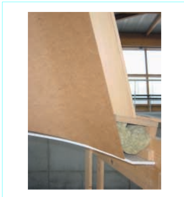
Figure 10 – Panneau de fibres dur mis en œuvre sur une ossature courbe (source : Marie-Christine Trouy-Triboulot, ENSTIB)
