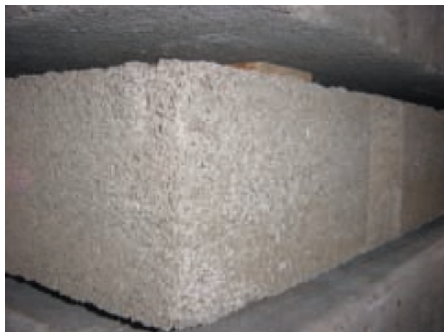
Figure 12 – Dalle en béton de bois
