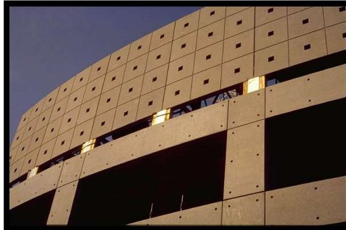
La paroi extérieure visible est réalisée la plupart du temps à l'aide d'un béton architectonique ne nécessitant pas de finition complémentaire après mise en œuvre. Il est toutefois possible de réaliser un traitement complémentaire (protection, peinture, enduit) lors de la mise en œuvre ou en réhabilitation.
