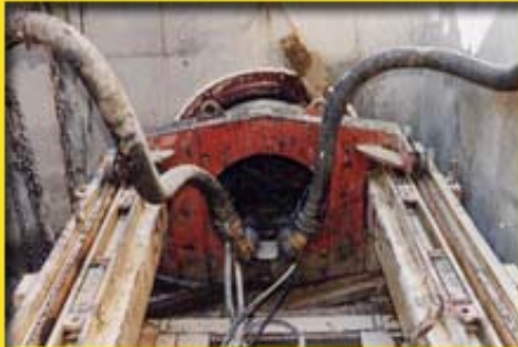
Microtunnelier avec son noyau de marinage
