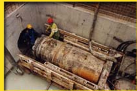
Microtunnelier en preparation
