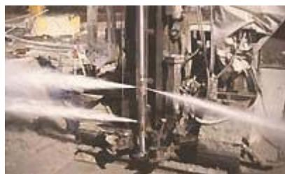
On désigne par jet grouting un procédé de construction utilisant un jet de fluide à haute énergie cinétique pour détruire un terrain et le mélanger avec un coulis liquide. Il ne s'agit donc pas exactement d'une technique d'injection, mais plutôt d'un procédé de mélange hydrodynamique terrain-coulis visant à former un « béton de sol » in situ dans la masse du terrain.
