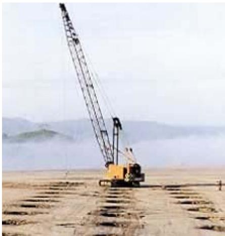
Il s'agit d'un procédé (1965-L. Ménard) qui consiste à pilonner le sol en surface avec une masse. L'énergie transmise par chaque impact pénètre dans le sol et produit une déstructuration. Au bout de quelques jours (ou semaines), une restructuration s'opère qui aboutit à des caractéristiques de portance améliorées.
