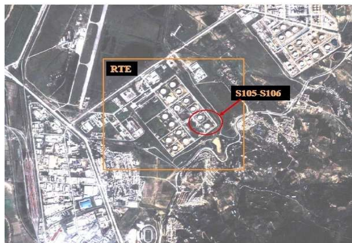
Figure. 2.7. Présentation du terminal de Skikda
