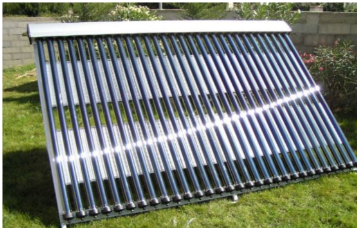
Fig.2.22 Capteurs sous vide [21]
