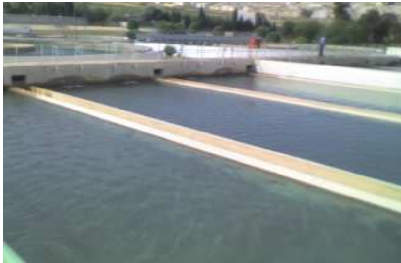
Photo 6 : filtre à sable.
