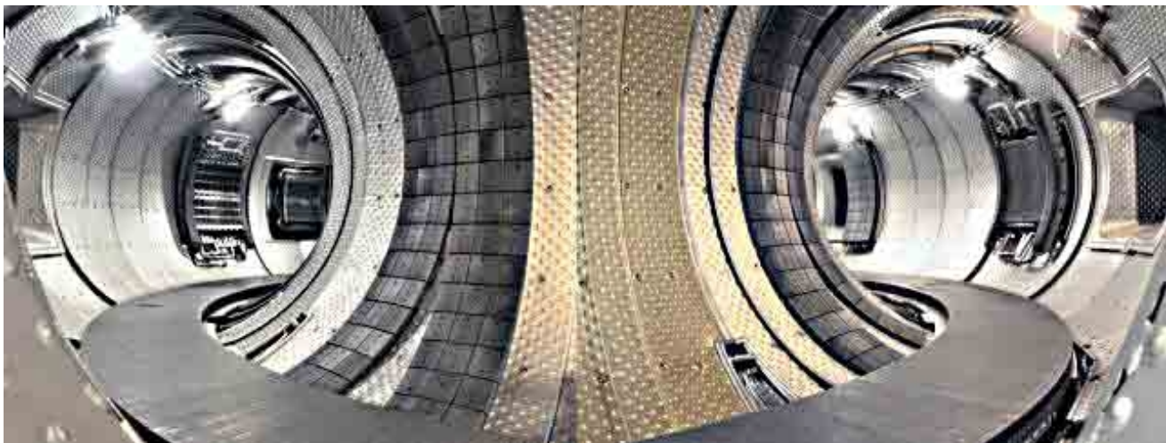
Chambre de Tore-Supra Source CEA figure 10
