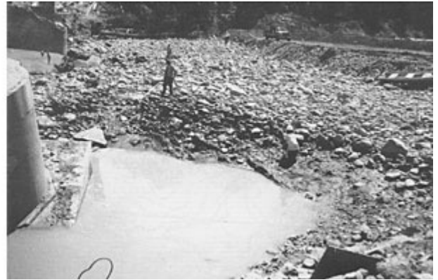
Photo I.15: Le pont de Schoharie Creek à New York, détruit par l'affouillement (5 avril 1987)
