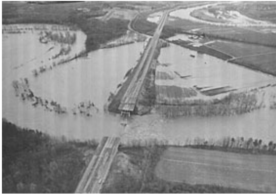
Photo I.15: Le pont de Schoharie Creek à New York, détruit par l'affouillement (5 avril 1987)
