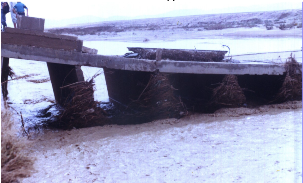
Photo I.12: L'état du pond enjambant Oued Barika après le passage de la crue de 1998
