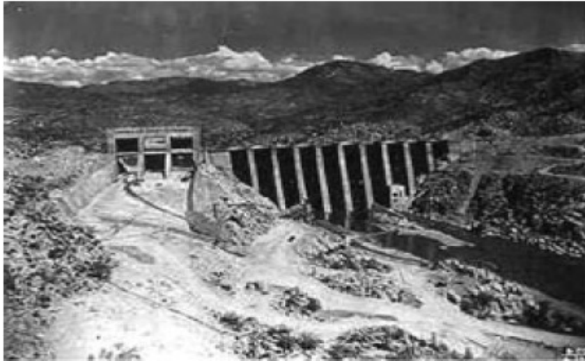
Photo I.1: Le barrage Bartlett sur la rivière de Verde River en Arizona (Photo: Bureau of Reclamation, US Department of Interior).
