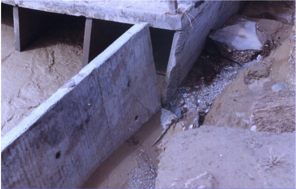
Photo I.12: L'état du pond enjambant Oued Barika après le passage de la crue de 1998
