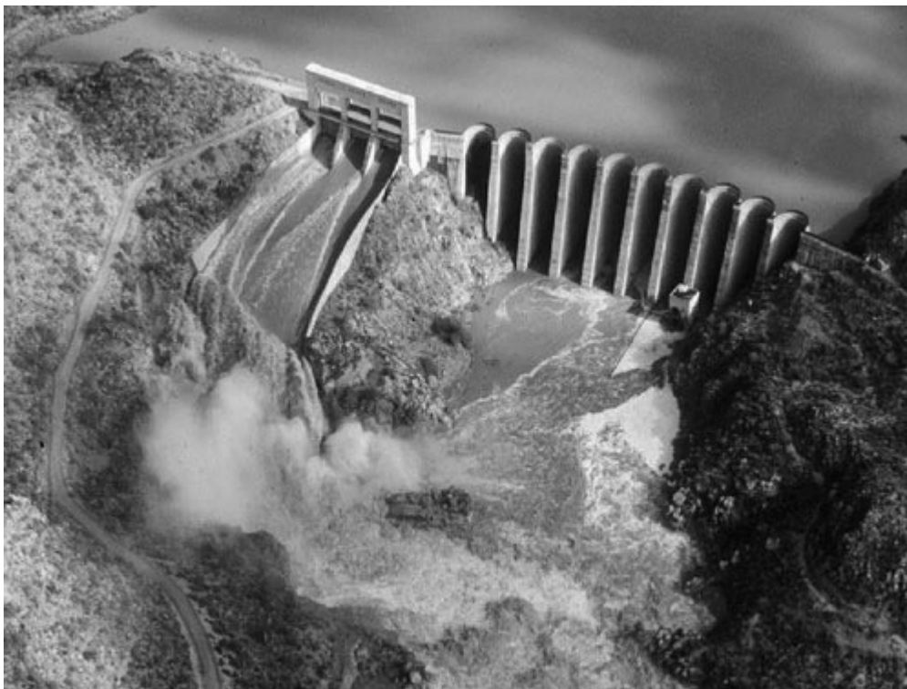
Photo I.3: L'évacuateur de crue du barrage Bartlett durant l'événement de 1978
