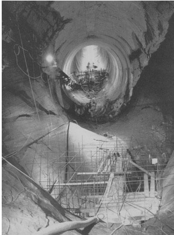
Photo I.8: travaux de remise en service du tunnel d'évacuation
