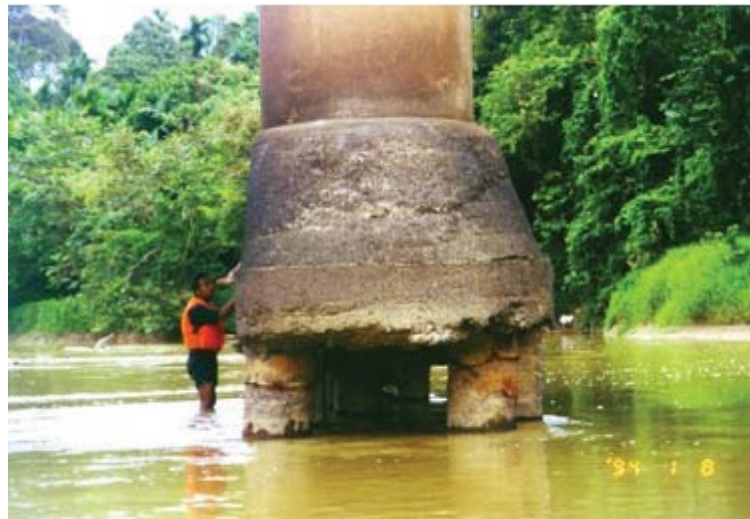
Photo II.2 : L'affouillement général de la rivière de Sg. Jeniang, Kedah [27]
