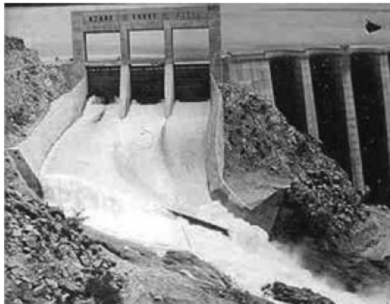
Photo I.2: L'évacuateur de crue du barrage Bartlett (en débordement en 1941 : Photo of Bureau of Reclamation, US Department of Interior).
