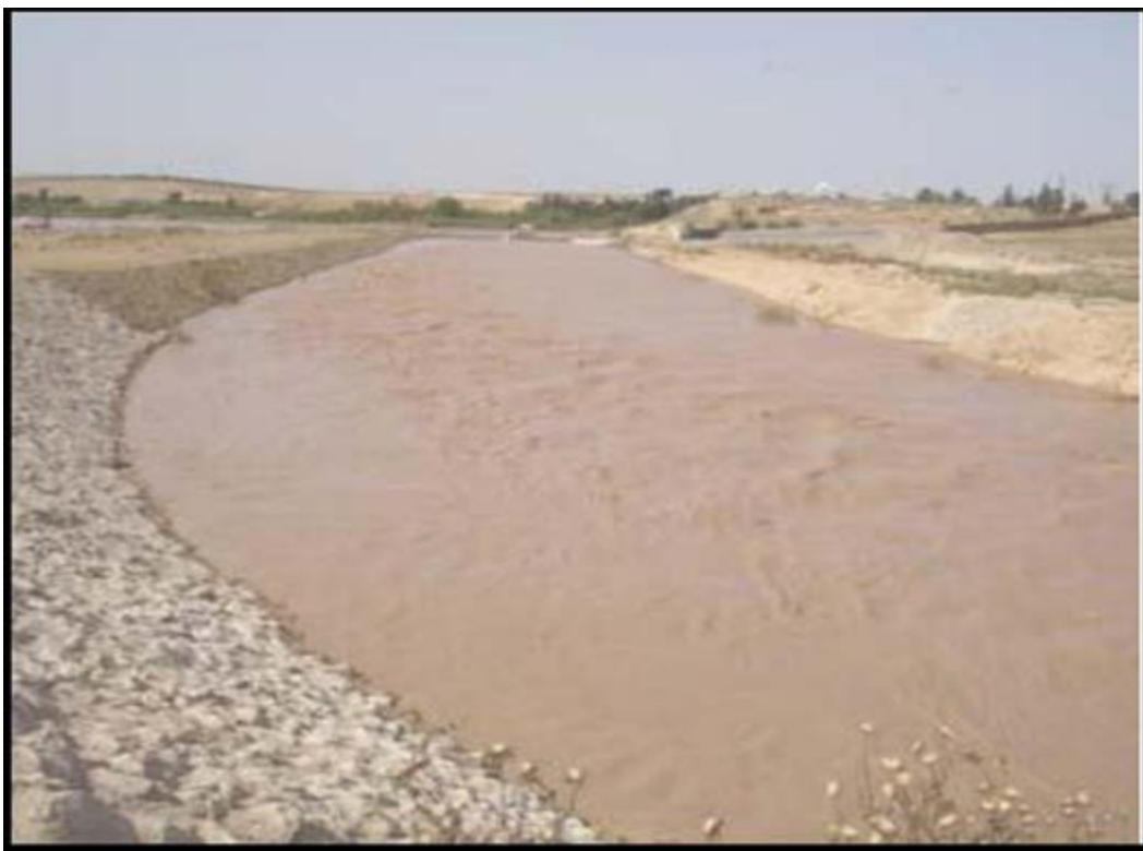
Figure 1.17 : Canal de dérivation au Sud de la ville de Sidi Bel Abbés (Hallouche B., 2007).
