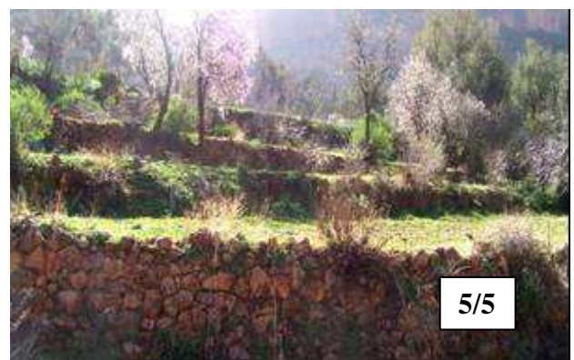
TERRASSES AVEC MURETTES
