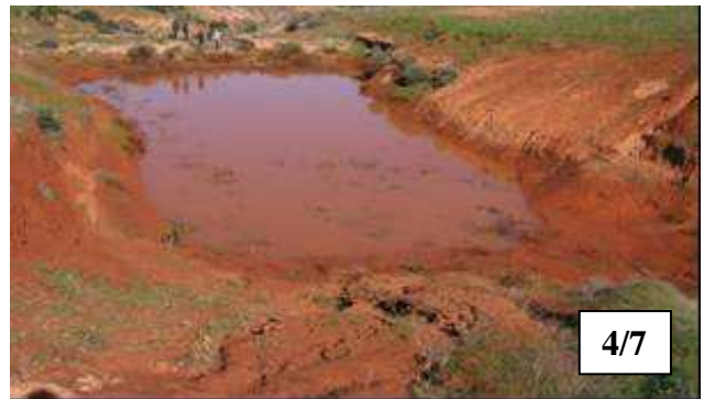
ENVASEMENT DES DIGUETTES
