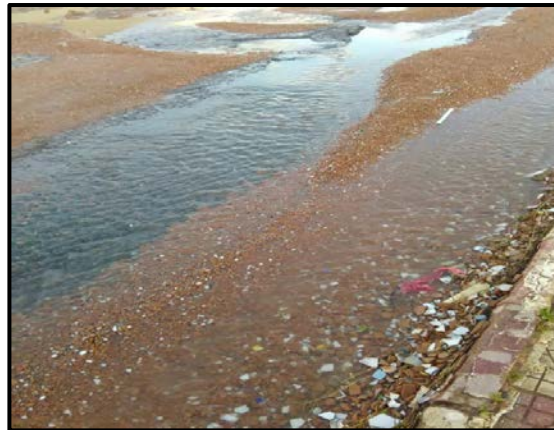
Figure III.3 : Fuites au niveau du réseau de Remchi
