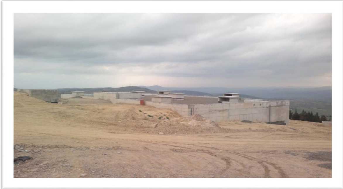
Photo II.5 Réservoir de SOUK LKHEMISS RT1 [31]
