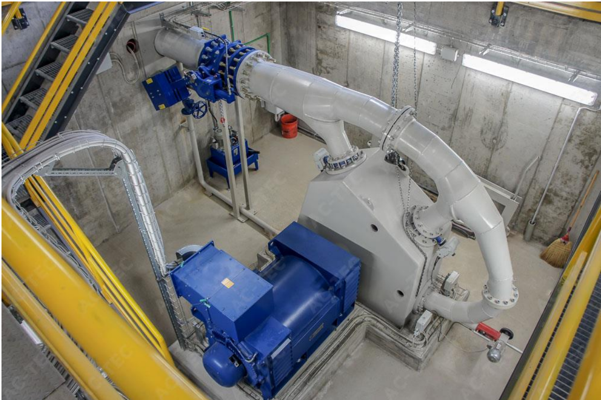
Figure III.5 Turbine à trois injecteurs [19]
