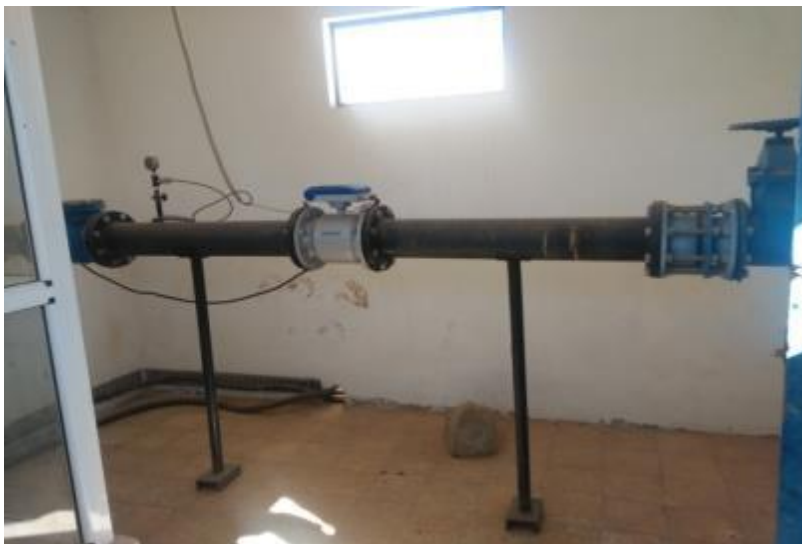
PhotoIV.4 : L'équipement hydraulique de forage B2.
