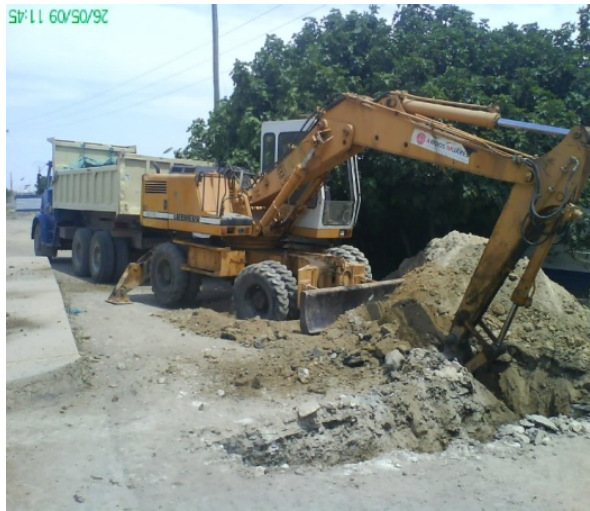
Figure IV.12: Démolition et terrassement (SEOR, 2019).
