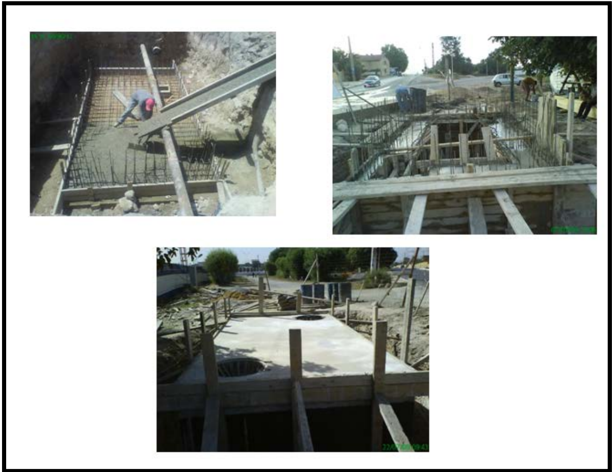
Figure IV.14: Etapes des Travaux génie civil (SEOR, 2019).
