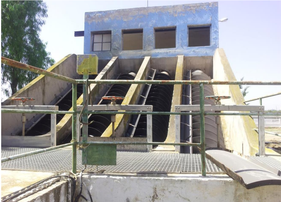
Figure III.4 : Photo de bâtiment de relevage.
