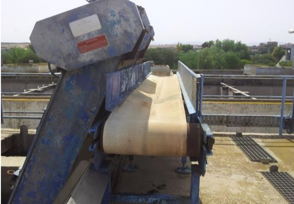
Figure III.7 : Photo de la bande de transport des refus de dégrillage.
