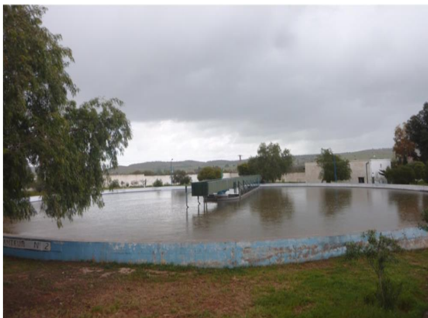
Figure III.12 : Photo de décanteur secondaire.
