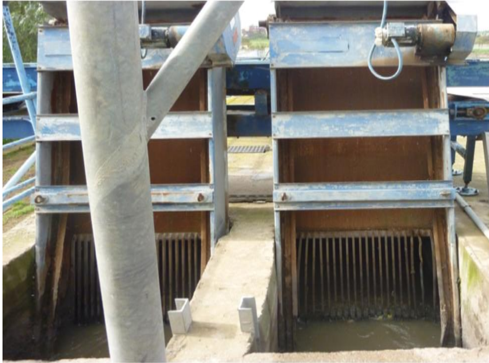
Figure III.5 : Photo de la grille fine mécanisée (02 unités).
