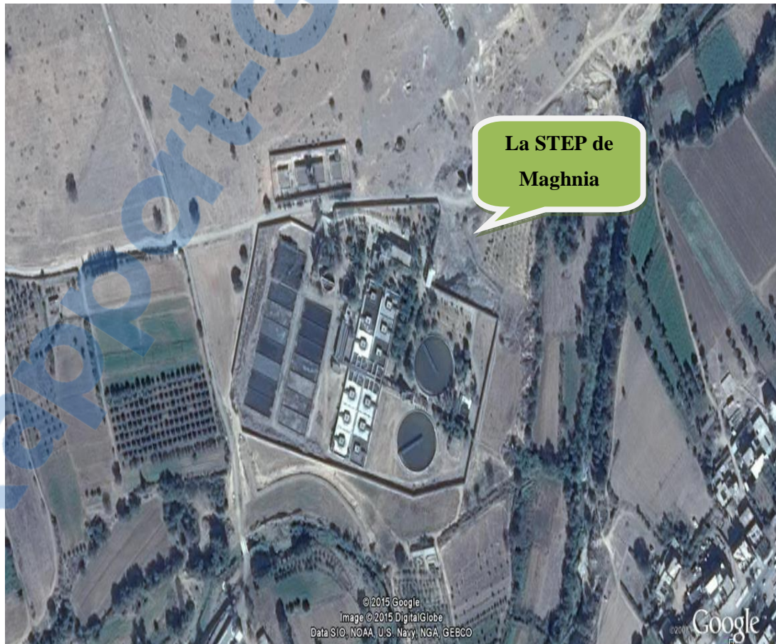
Figure III.1: Vue de la station d'épuration de la ville Maghnia [20].
