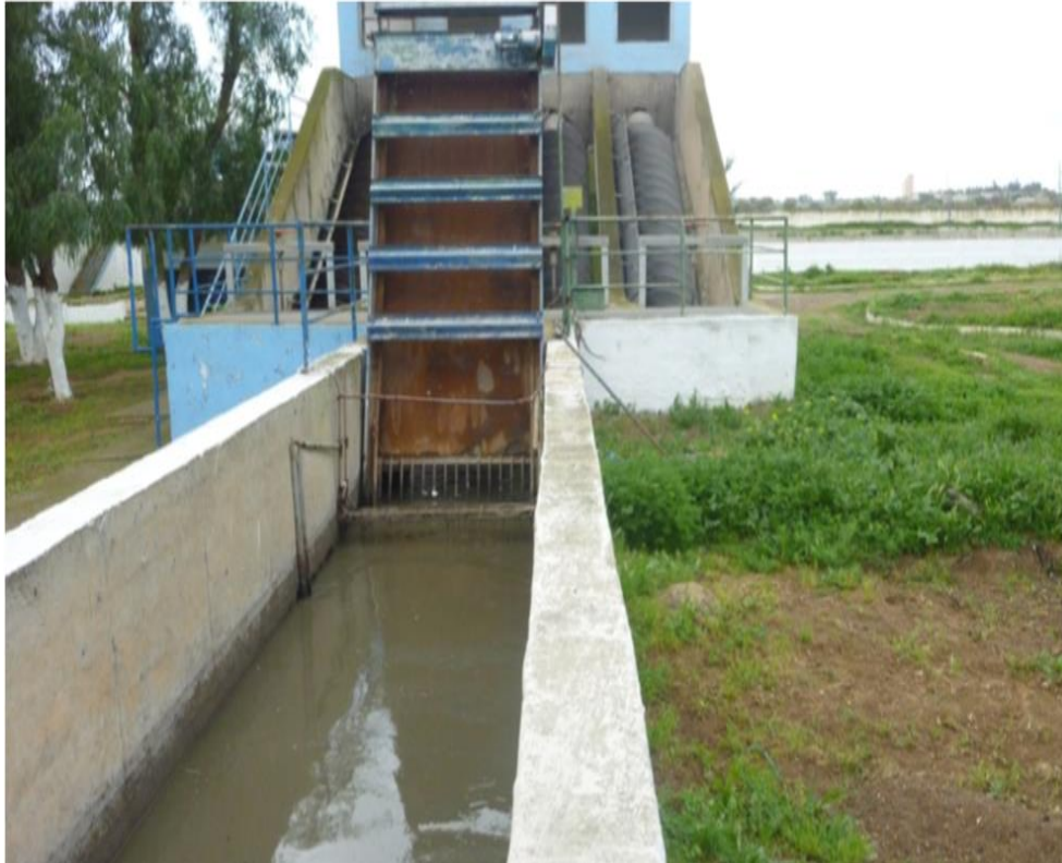
Figure III.3 : Photo de la grille grossière mécanisée.
