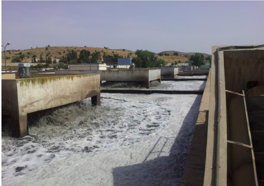
Figure III.11: photo des bassins d'aération.
