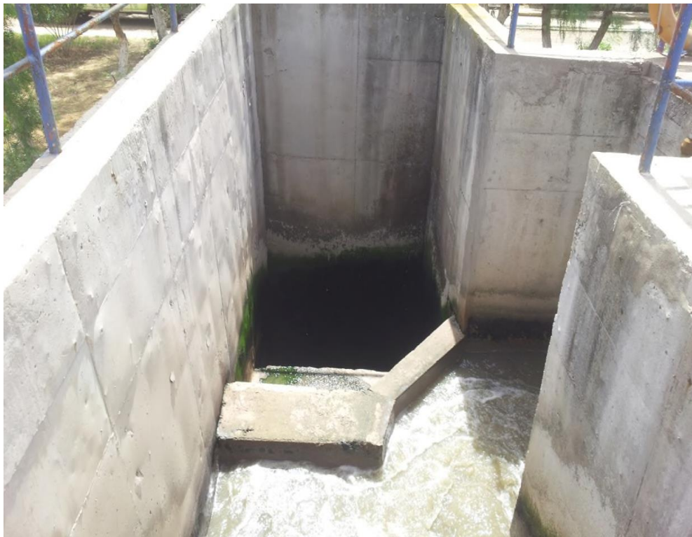
Figure III.2: Photo du déversoir d'orage.
