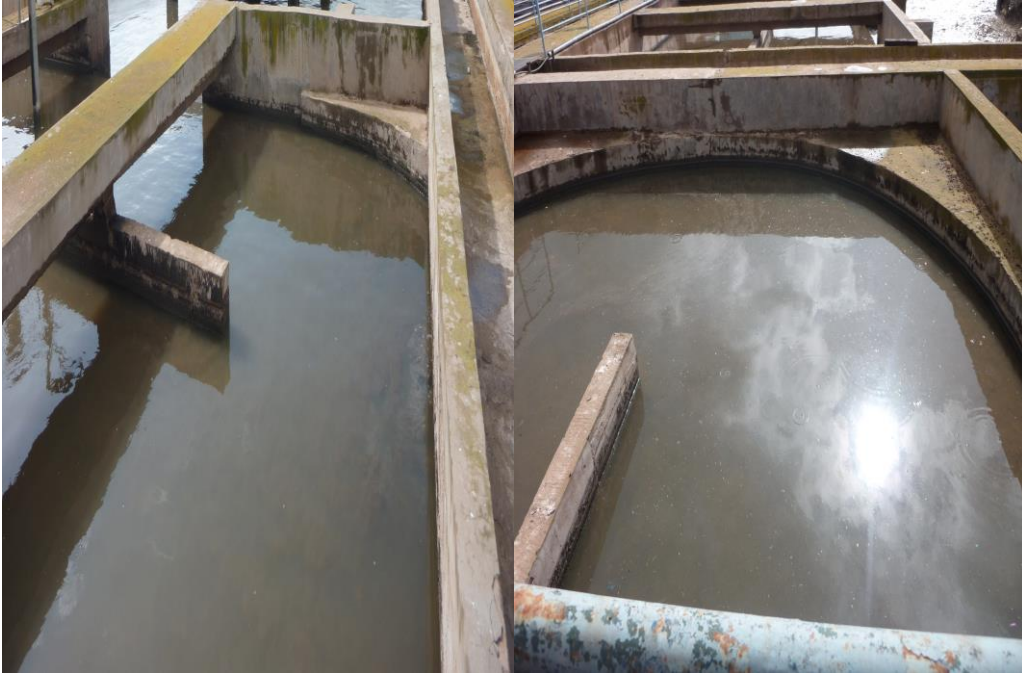
Figure III.10 : Photo des bassins de dénitrification.
