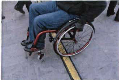
Photo 7. Cache-câble plus fin. protection.
