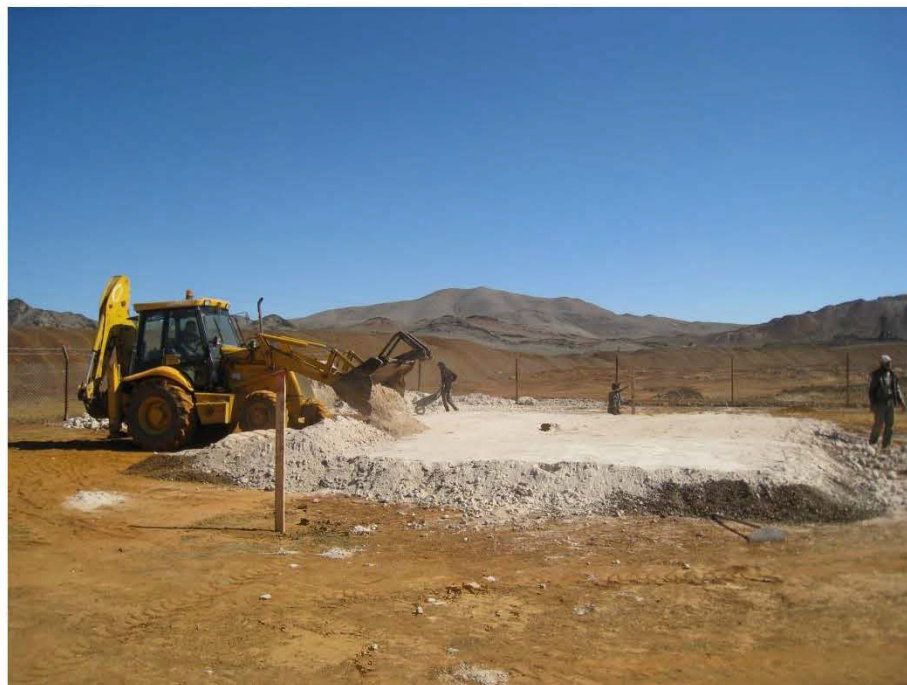
Figure G.9 Dépôt des rejets calcaires phosphatés sur les rejets grossiers de Kettara.
