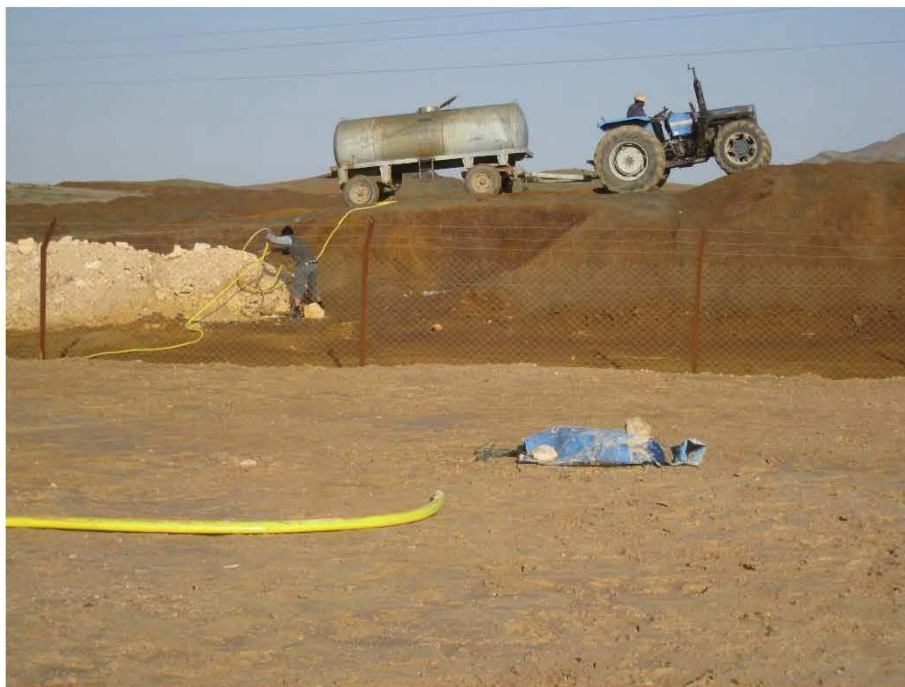
Figure G.13 Installation de la citerne d'eau sur la digue.
