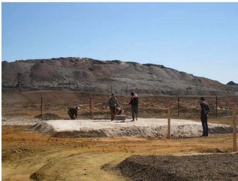
Figure G.8 Installation des rejets calcaires phosphatés et compactage.
