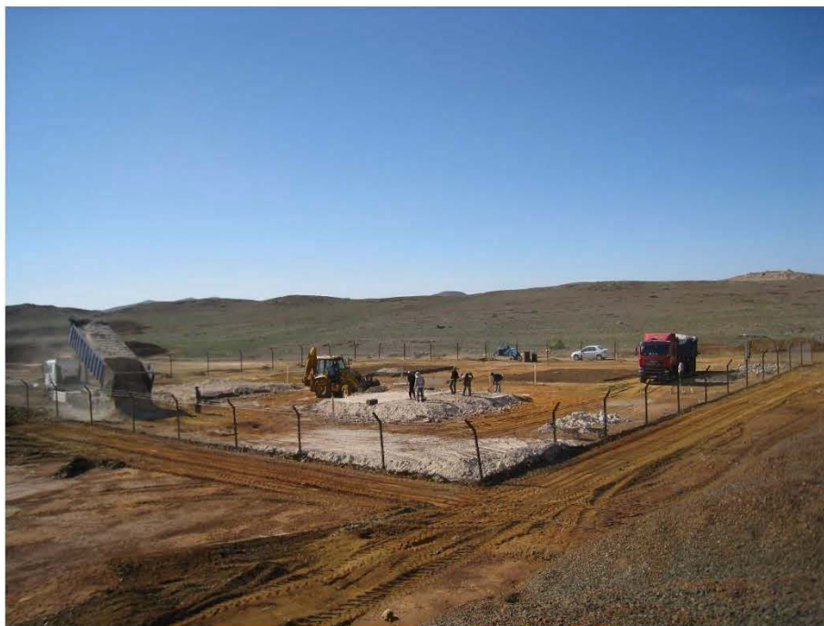
Figure G.10 Transport et entreposage des rejets calcaires phosphatés sur le site.
