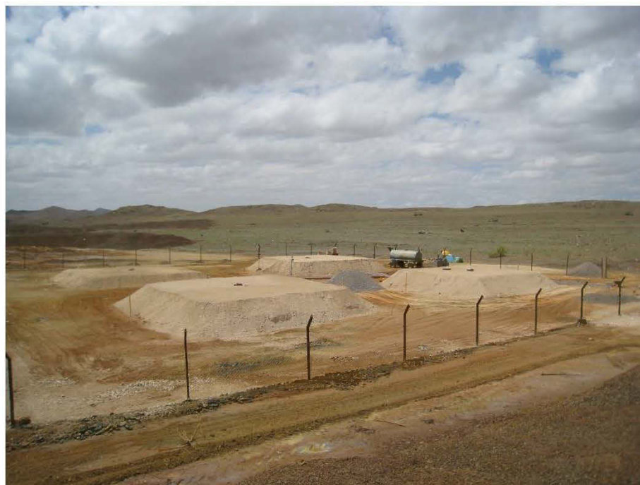
Figure G.12 Vue des cellules expérimentales terminées.
