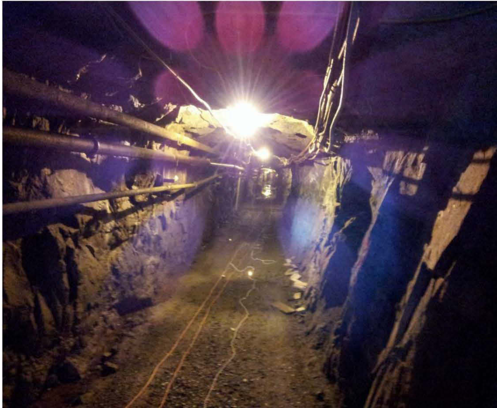
Figure 4-4 : Galerie minière au niveau 70m.
